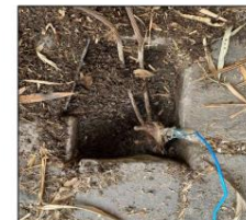
Figura 5: Ponto de inspeção haste
